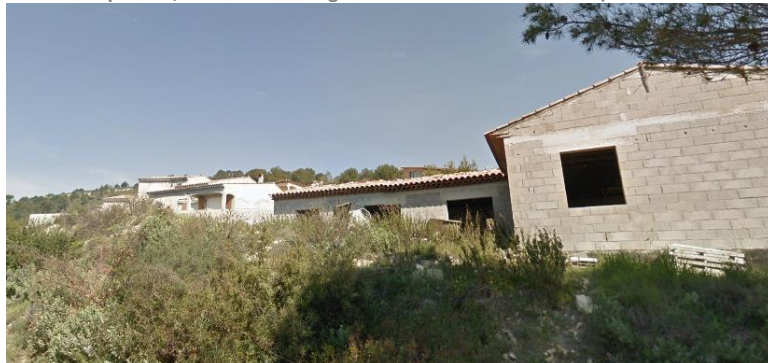
Au sud, on remarque des constructions plus récentes, présentant les mêmes typologies du bâti (Source : Streetview)
